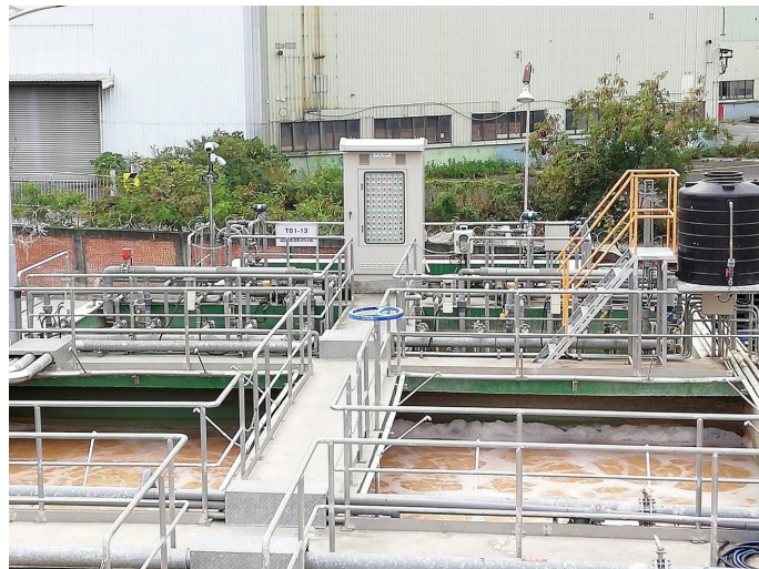
圖 2-8 污水處理場示意圖
